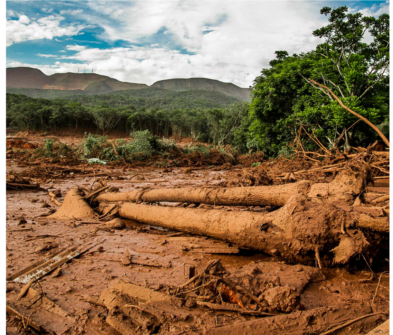
2019 brach in der Nähe der Kleinstadt Brumadinho ein Damm eines Rückhaltebeckens für die Erzschlammreste. Auch in dem Tailingsbecken der von der KfW finanzierten Quebrada Blanca Kupfermine wurden Risse entdeckt. Foto: Jeso Carneiro Lizenz: CC BY-NC 2.0
