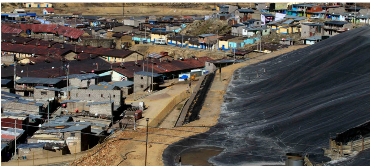
Die Abraumhalde der Toromocho-Mine reichte schon 2012 bis nach Morococha. Inzwischen wurden die Bewohner*innen enteignet und umgesiedelt. Foto: picture alliance / REUTERS | PILAR OLIVARES
