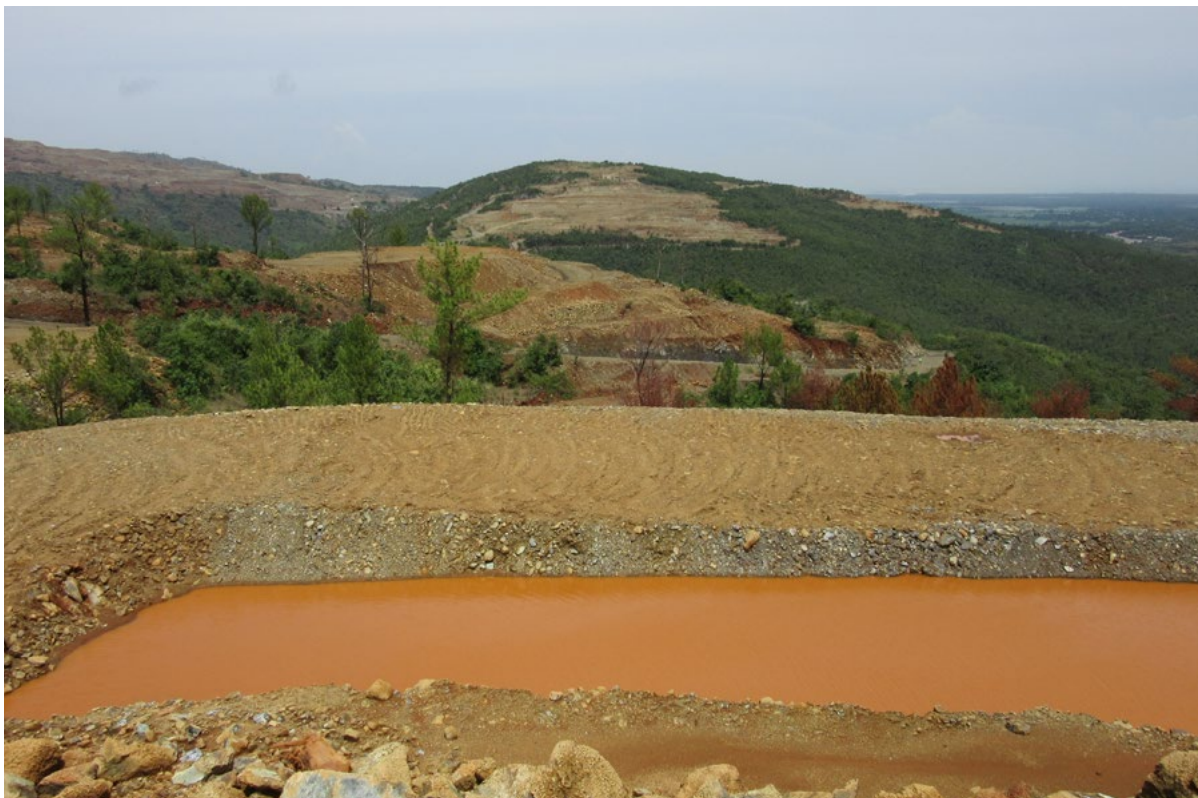
Neues Nickel-Absatzbecken, nachdem das alte einem Hangrutsch zum Opfer fiel Foto: Michael Reckordt
